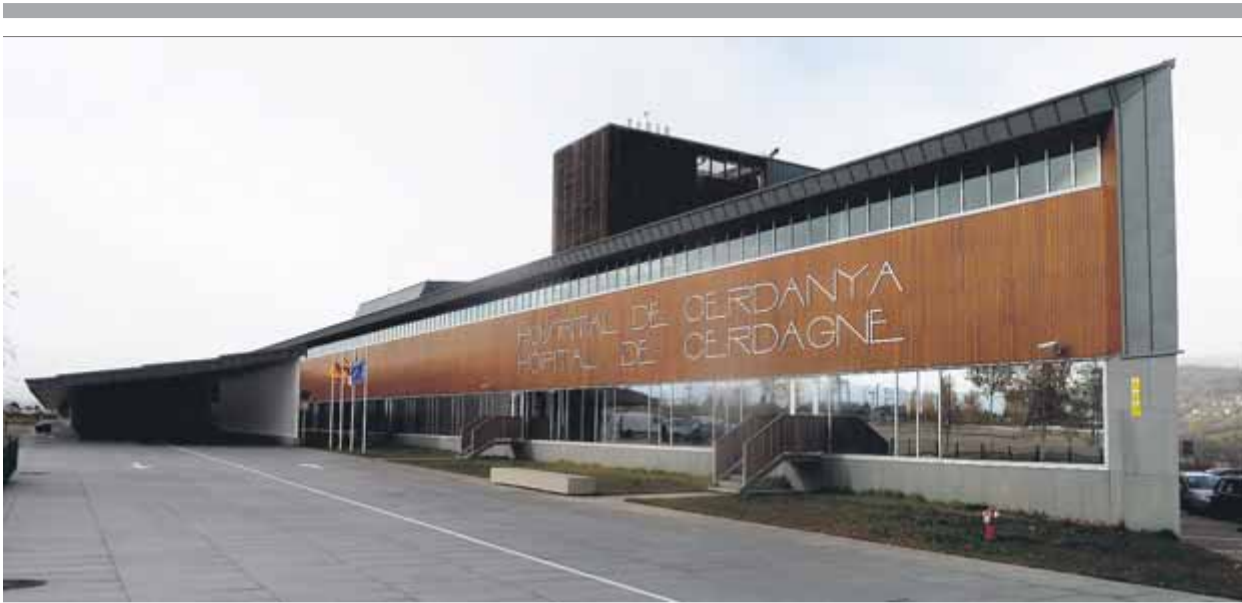
Una vista general de la façana principal del centre hospitalari transfronterer, situat al pla de Rigolisa de Puigcerdà ■ J.C.
